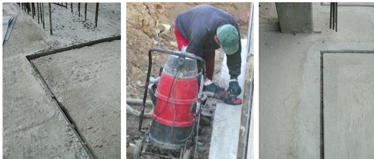
Rys.3: Przygotowanie podłoża.
