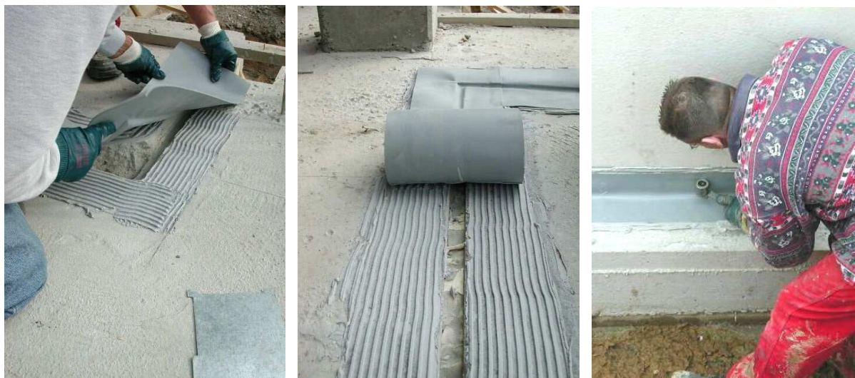
Rys.6: Wklejanie elementu uszczelniającego.
