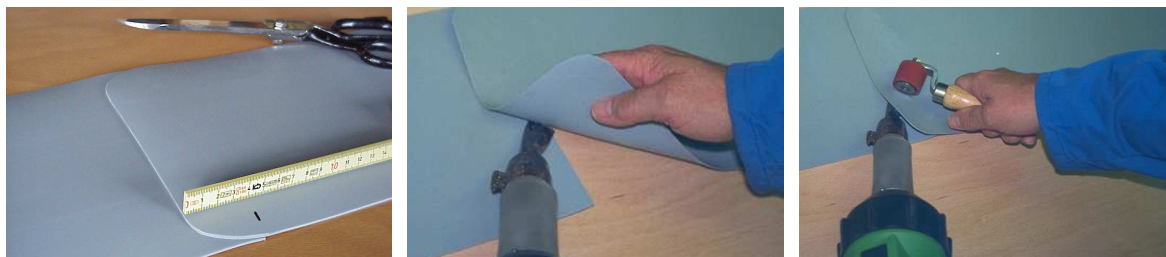
Rys.10: Spawanie zakładkowe membrany Tricoflex.
