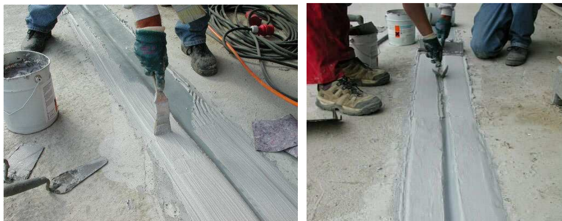
Rys.7: Nanoszenie wierzchniej warstwy kleju
