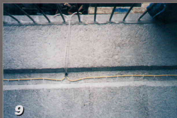
Przerwy robocze płyt fundamentowych
