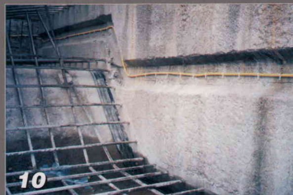
Połączenia płyt fundamentowych ze ścianami szczelinowymi
